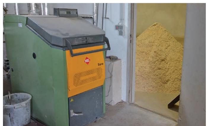
Weil bei Sägespaltern stets viel Splintholz und Späne anfallen, heizt Jochen Döhla mit einem Holzvergaser der Firma HGD vom Typ Euro V3.0 mit 30 Kilowatt Nennwärmeleistung und 3.200 Liter Pufferspeicher. Der Kessel frißt fast alles: Scheitholz bis zu einem halben Meter Länge, Hackschnitzel, Späne sowie Holzabfälle wie Spanplatten. Eine Holzfüllung reicht für einen Tag, mit Spänen aus dem Spänebunker (rechts) muß der Kessel zwei- bis dreimal täglich befüllt werden.
